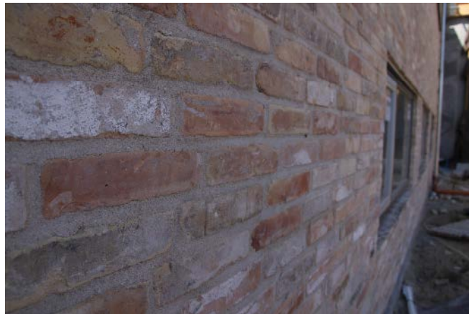
Figur 2: Genbrugssten i facademuren.
